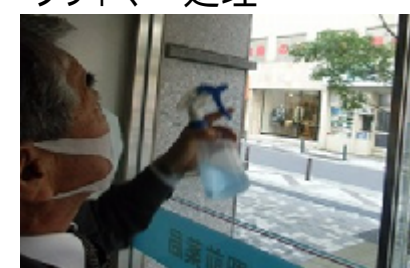
プライマー処理
