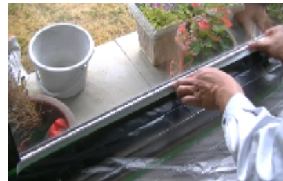
シーリング部保護養生
