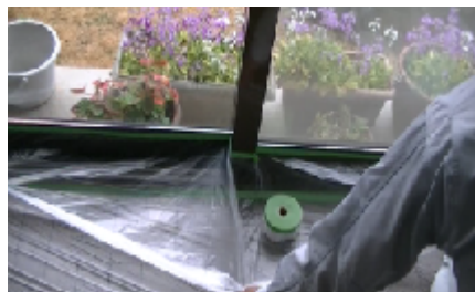
床面・壁面の保護養生
